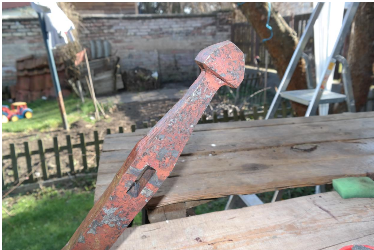
Svislé rohové sloupy rámu po odstranění nátěrů
