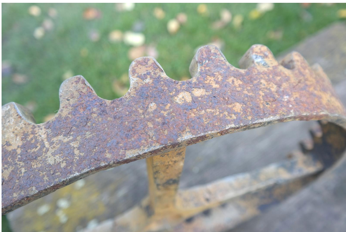
Detail silné vrstvy koroze na natahovacím kole jícího stroje orloje
