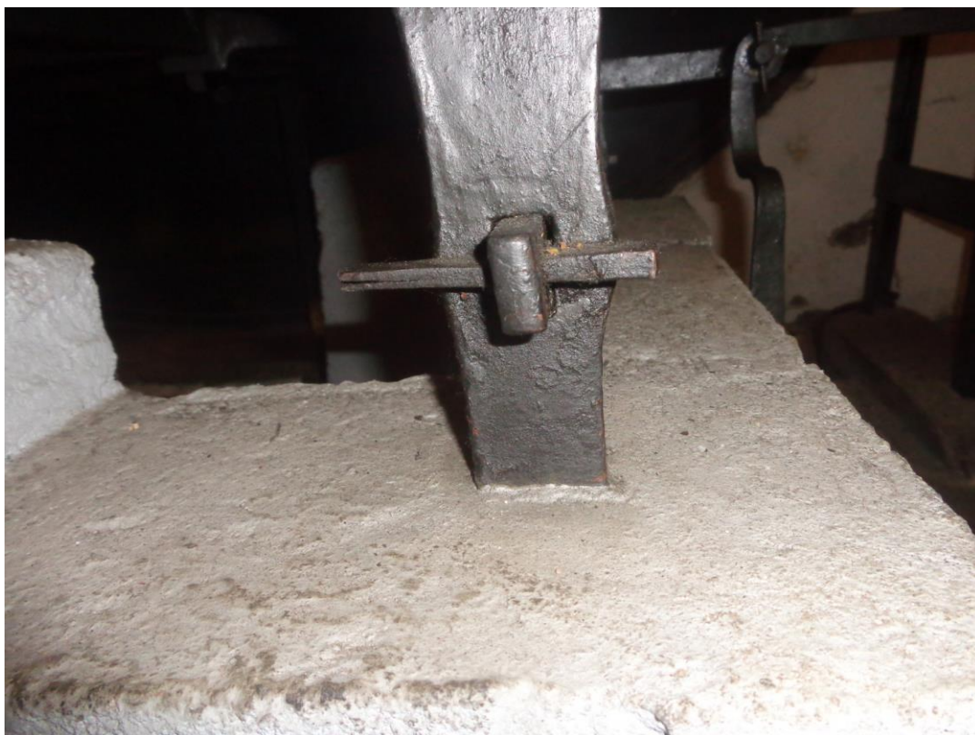
Zabetonovaná patka rámu bicího stroje
