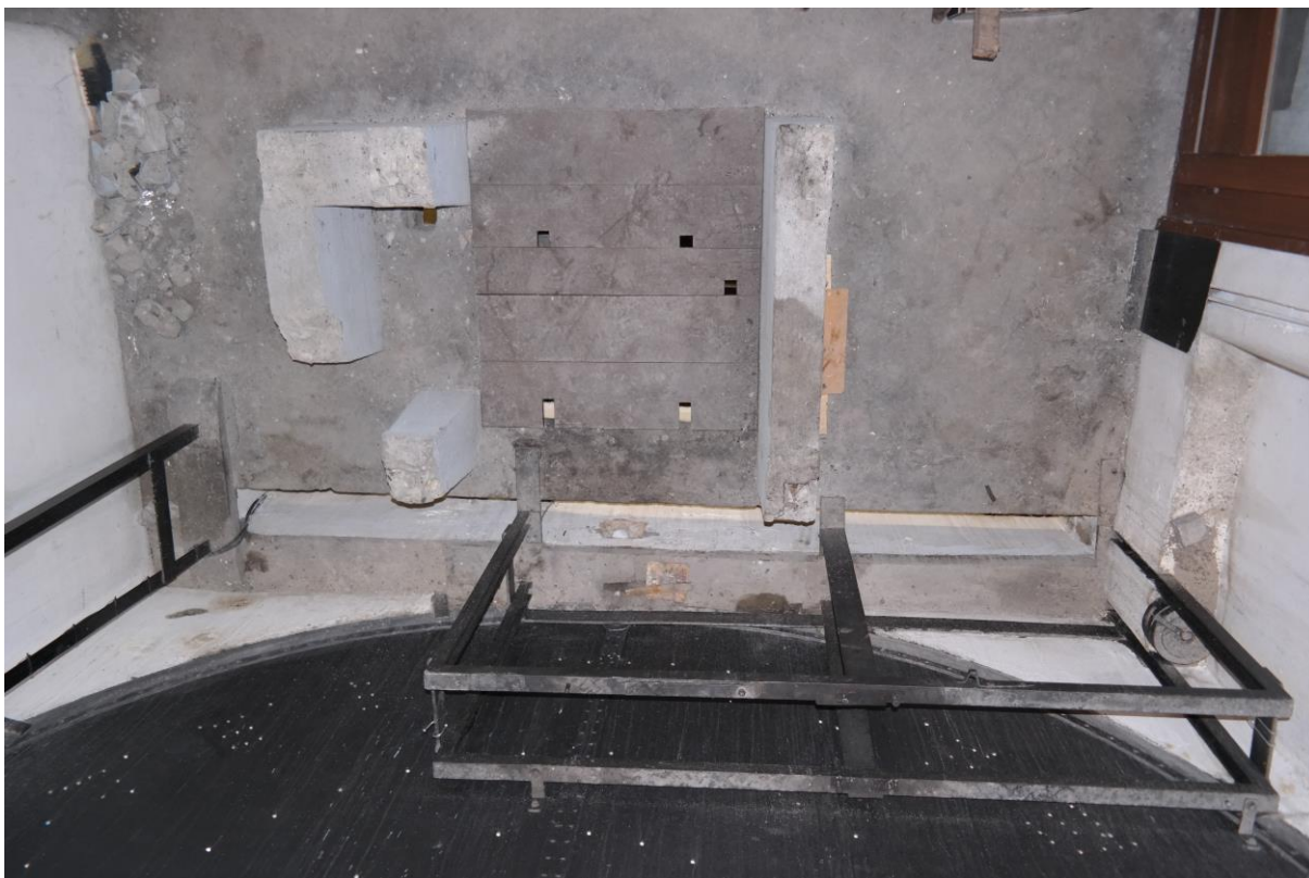
Betonový odstavec po demontáži stroje orloje
