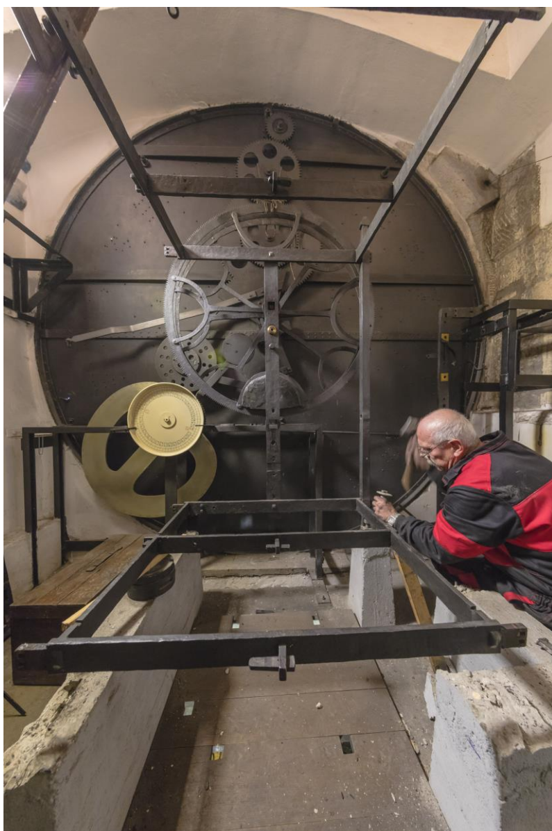
Demontáž stroje orloje
