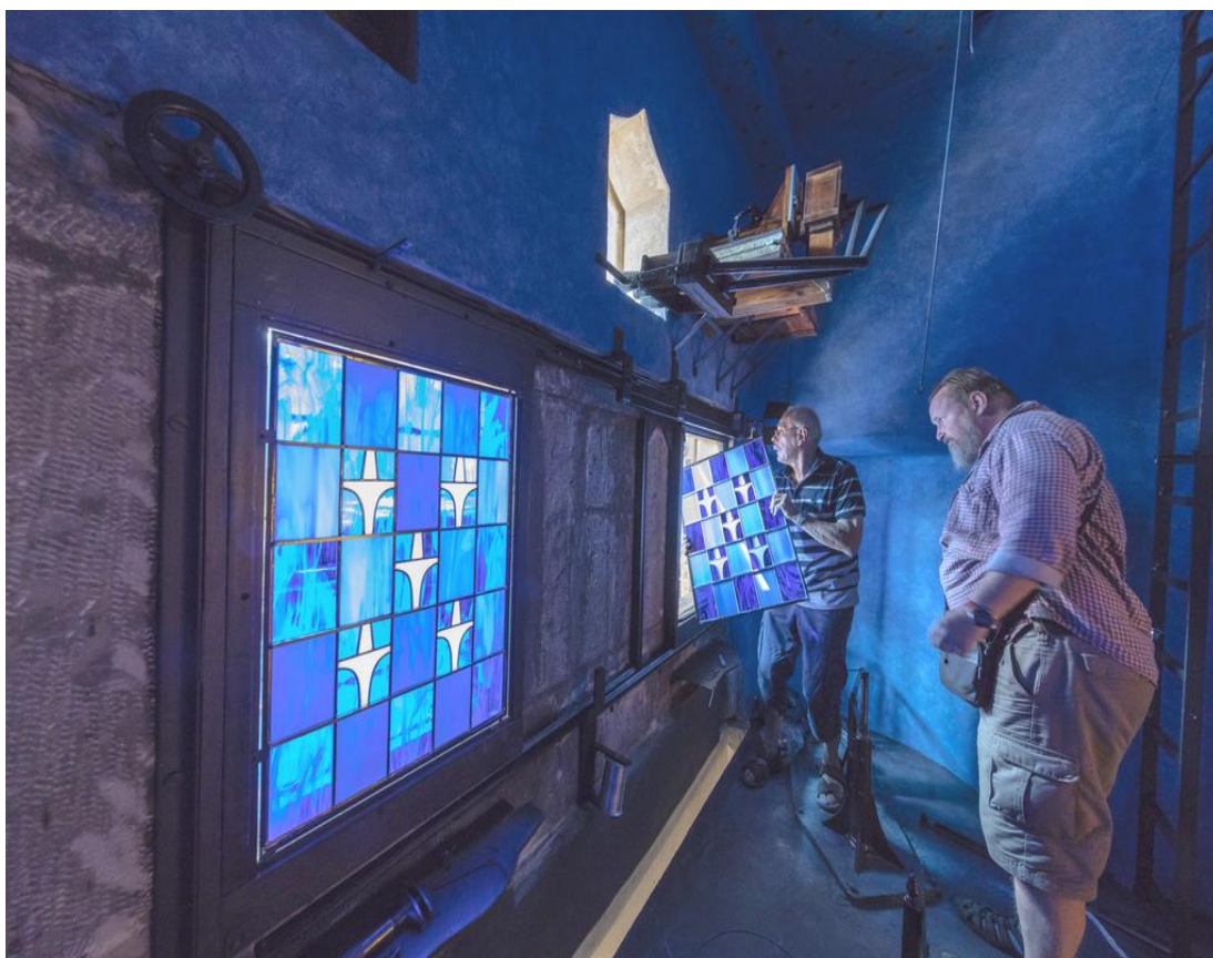
Osazování posuvných vitrážových okének do ráků s možností mírného pootevření ven
