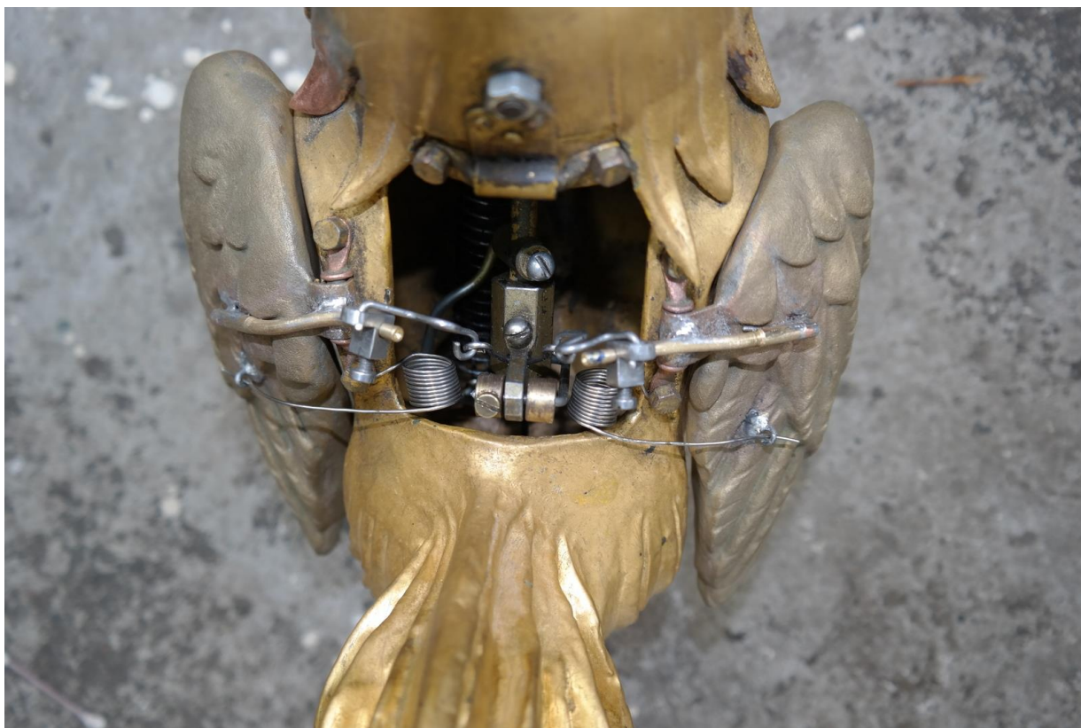
Hlava a mechanika kohouta po opravě
