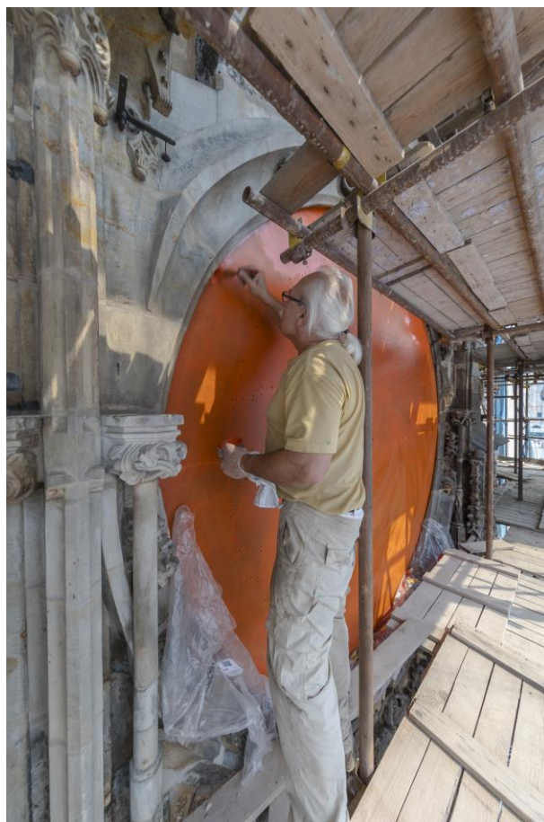
Natírání antikoroční suříkovou barvou a jednotlivé fáze omalby desky astrolábu
