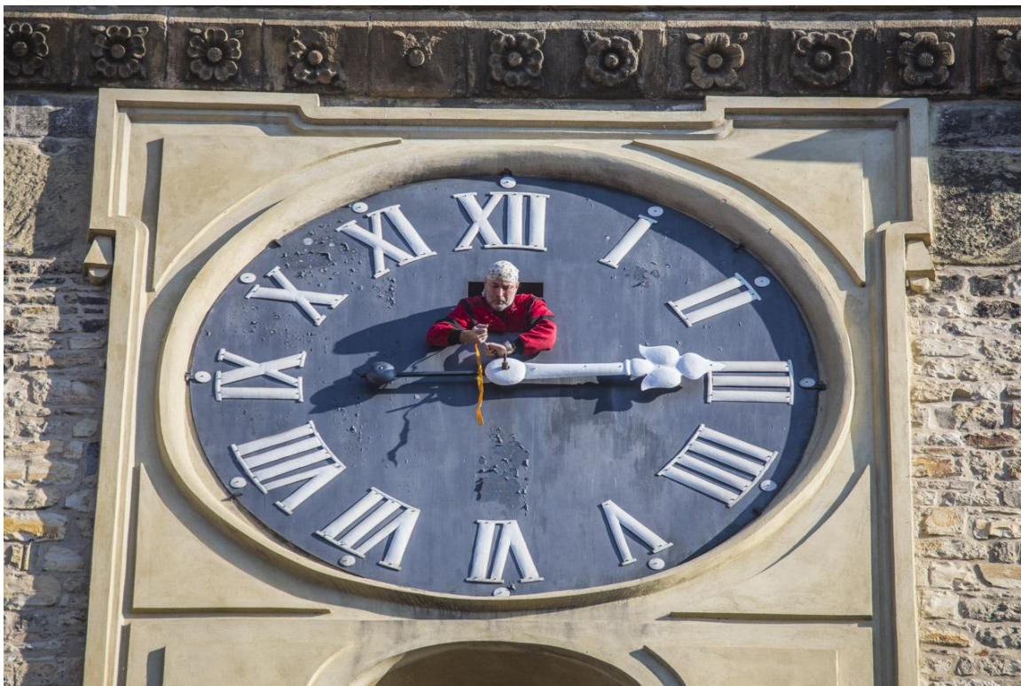
Demontáž ruček ciferníků. Stav povrchu západního ciferníku před demontáží
