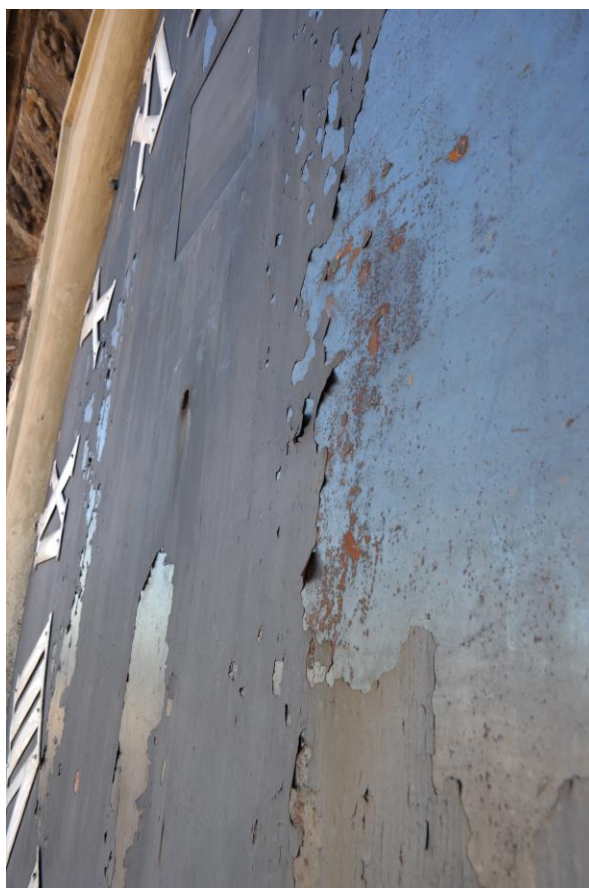
Demontáž ruček ciferníků. Stav povrchu západního ciferníku před demontáží
