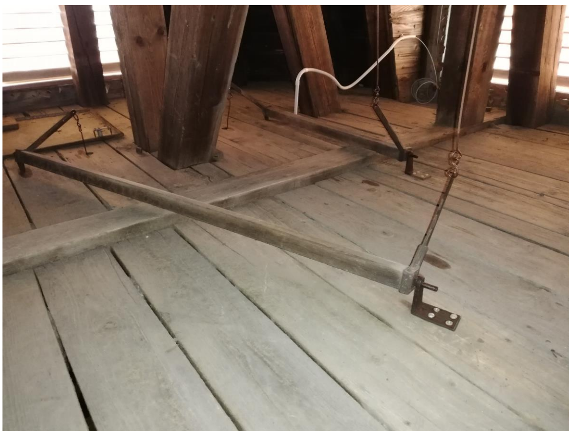
Převody tahové síly k paličkovým strojům před restaurováním a po zrestaurování
