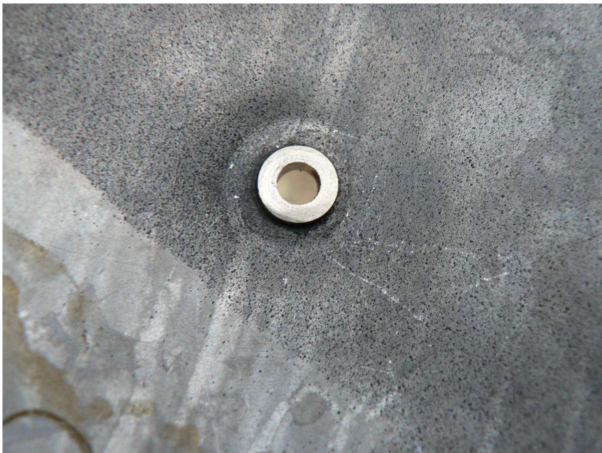
Nové ložisko v měsíční polokouli, pohled zevnitř
